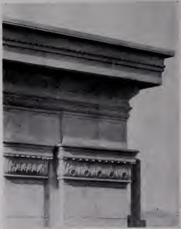
135. — Cornicione dei muri perimetrali
